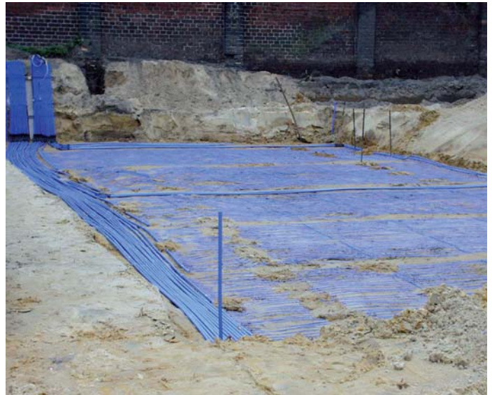
Erdwärme-Kompaktkollektor (Kapillarrohrsystem)
