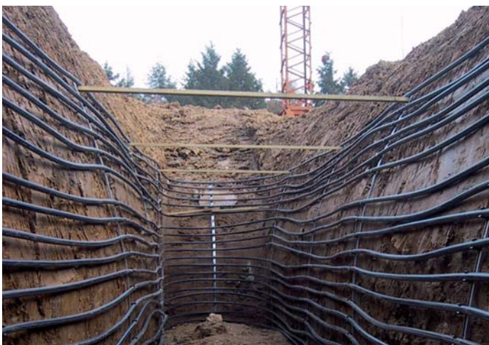
Einbau eines Grabenkollektors als flächensparende Variante
