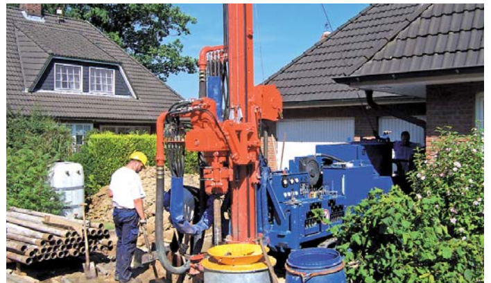
Bohrung für eine Erdwärmesonde Quelle: Heidelberger Geotechnik, Ennigerloh
