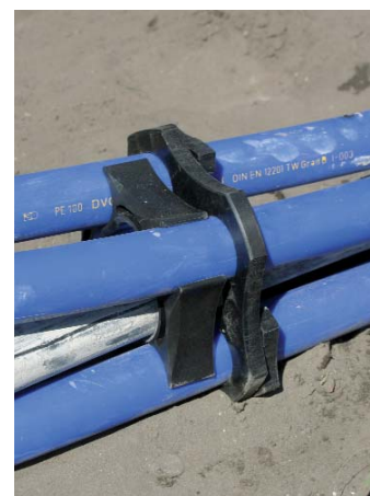
Durch die Abstandshalter wird die Sonde im Bohrloch zentriert; gleichzeitig trennen sie die einzelnen Sondenstränge voneinander.
