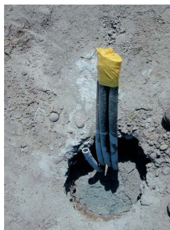
Verfüllte Bohrung mit eingebauter Erdwärmesonde
