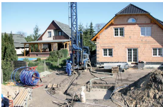
Bohrkran mit Spülungsgrube
