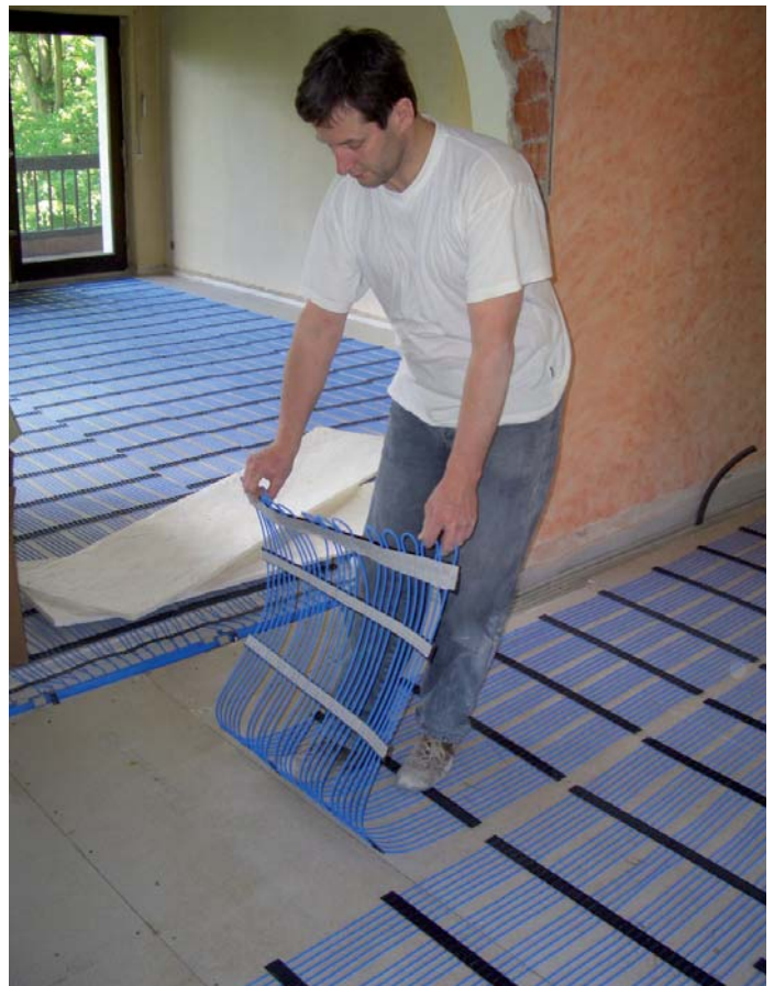
Einbau einer Fußbodenheizung (Kapillarrohrsystem) im Altbau. Die Vorteile der Erdwärmennutzung zeigen sich vor allem in Kombination mit Niedertemperatur-Heizsystemen.
