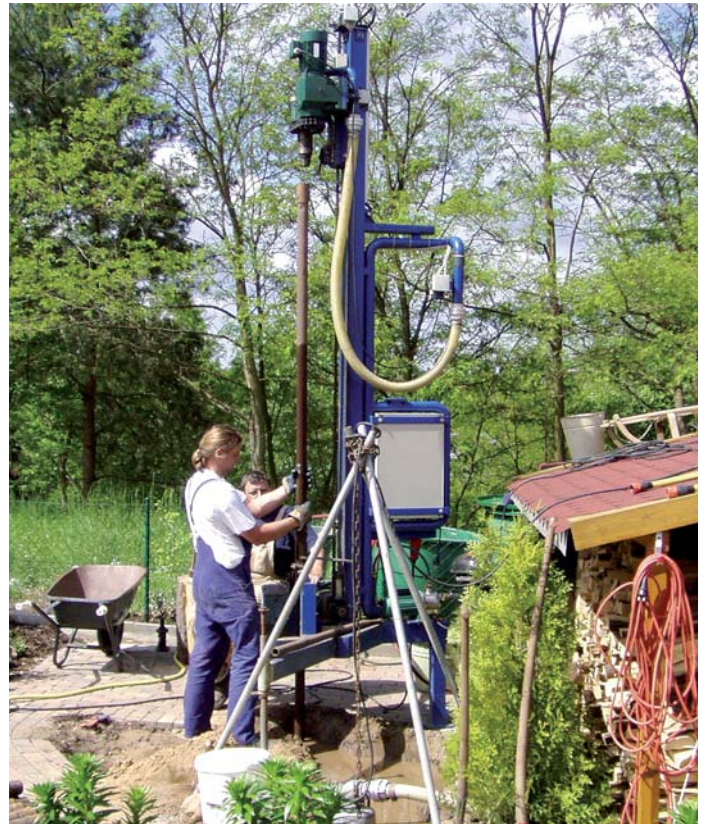
Kleine Bohrgeräte ermöglichen das Bohren auf engem Raum
